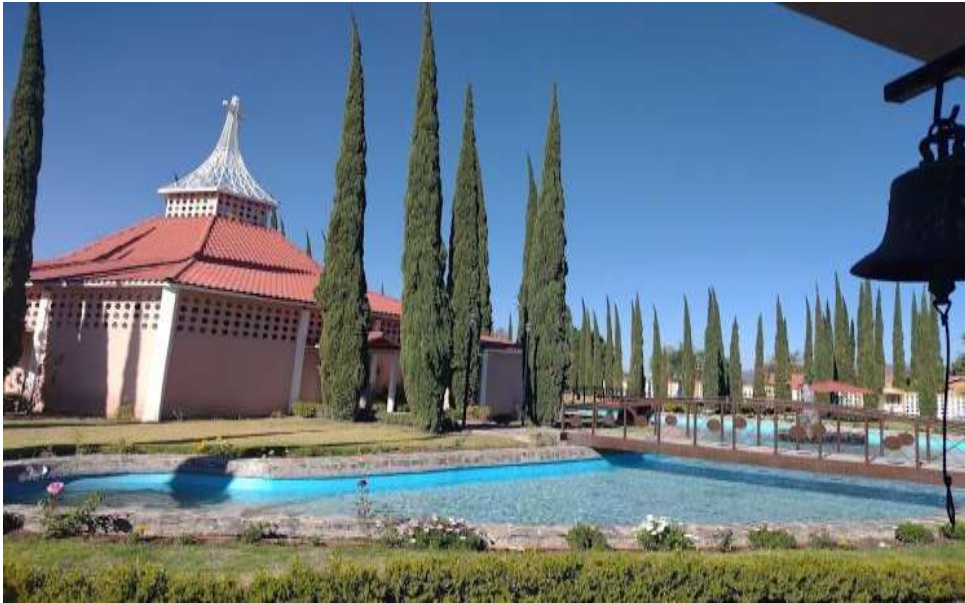
Instalaciones de la Casa
