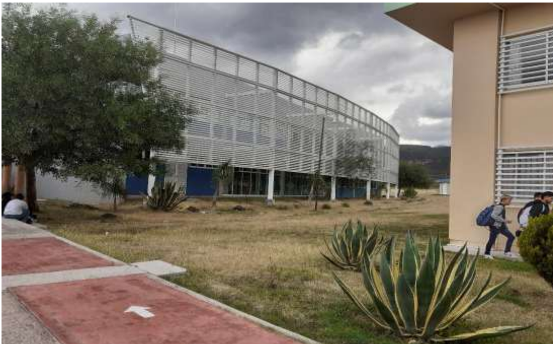
Instalaciones del ITESI
